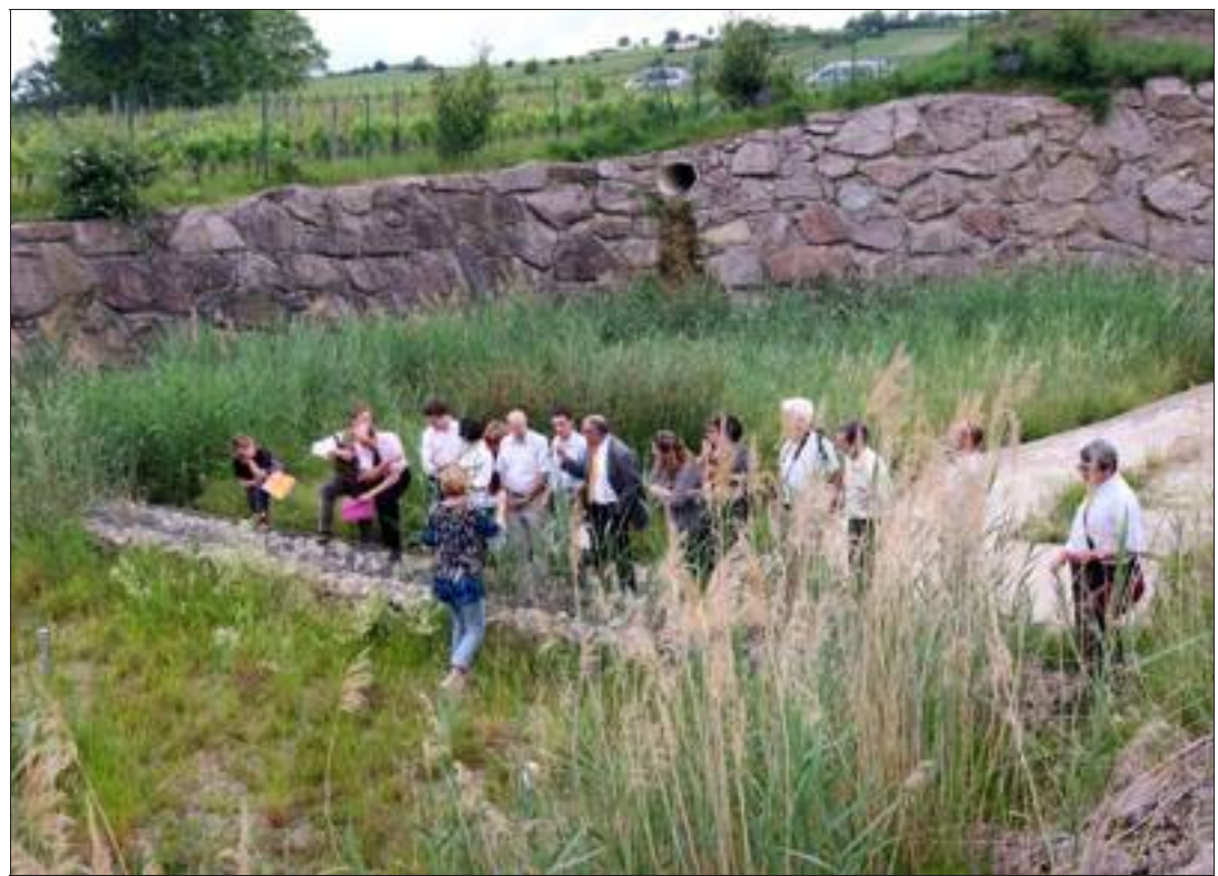
Le bassin d'orage du Waldweg, à Rouffach, équipé de lits filtrants de gravier et colonisé par les roseaux, permet de dégrader les résidus de pesticides charriés par les eaux de ruissellement. Photo T. Gachon
