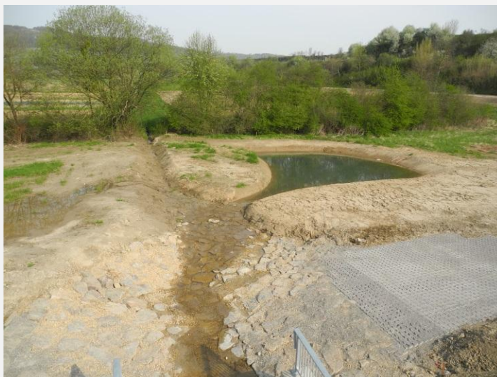
La zone humide réaménagée selon les prescriptions PhytoRet dans le bassin de rétention des crues de Steinenweg, commune d'Eichstetten
