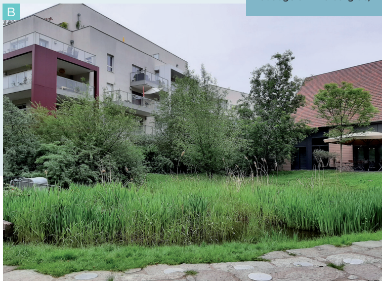
Dispositif d'infiltration des eaux pluviales du quartier d'Adelshoffen à Schiltigheim, instrumenté dans le cadre du projet NAVEBGO
