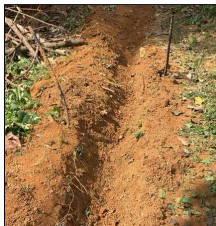
*Rigole pour canaliser les eaux pluviales jusqu'à la rivière*
