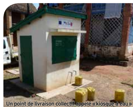
Un point de livraison collectif appelé « kiosque à eau »
