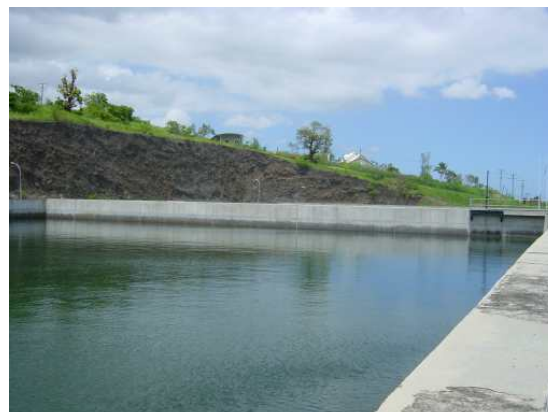
Bassin de décantation
