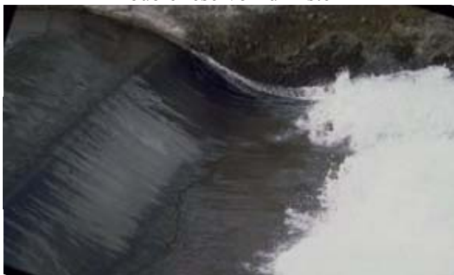
Seuil en rivière
